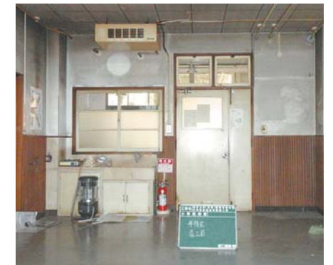
小学校1階事務室
