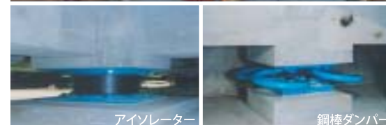
■免震構造の施工と免震装置
