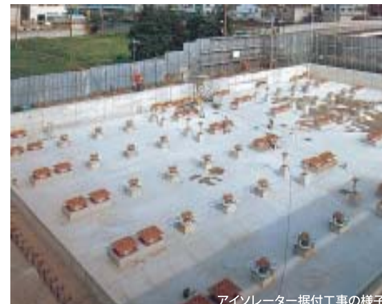
■アイソレーター据付工事の様子
