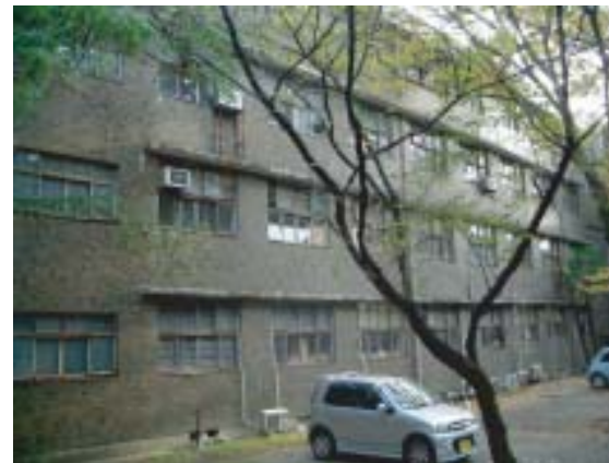
■中地区の旧基礎研究棟 取壊予定
