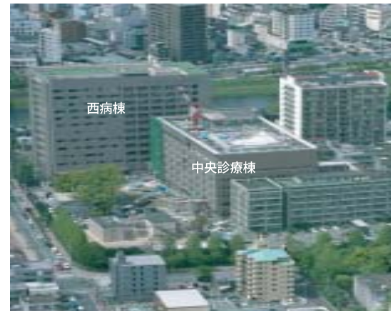
■免震構造を採用している西病棟と中央診療棟
